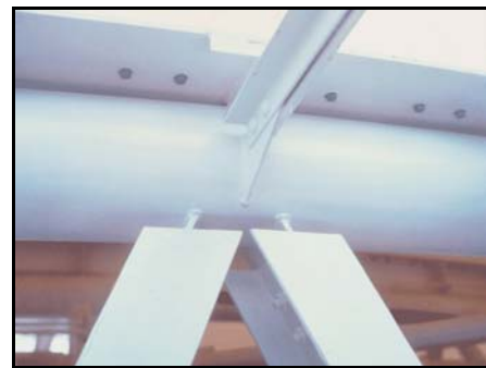
Peinture intumescente – vue d'un détail - esthétique conservé – Source Carboline
