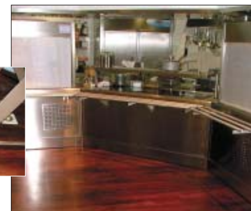
> Restaurant d'entreprise 1er étage de la Tour Eiffel. Parquet iroko M1 traité par sels ignifuges en station autoclave - Source Boismag.
