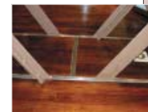
> Restaurant d'entreprise 1er étage de la Tour Eiffel. Parquet iroko M1 traité par sels ignifuges en station autoclave - Source Boismag.
