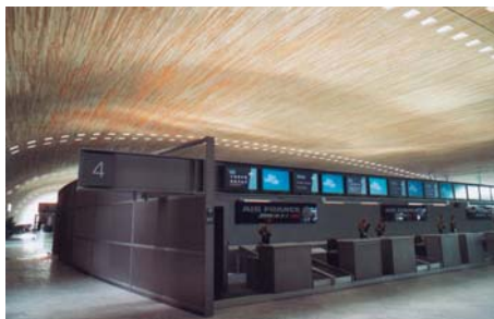
> Bois ignifugé M1 en autoclave - Aéroport de Roissy 2 - Terminal E
