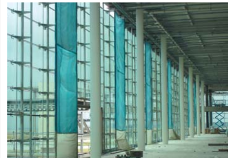
> Peinture intumescente sur poteaux acier - Roissy 2 - Satellite 3
